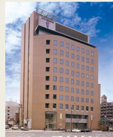
免震ビル（ニッタ本社ビル）
